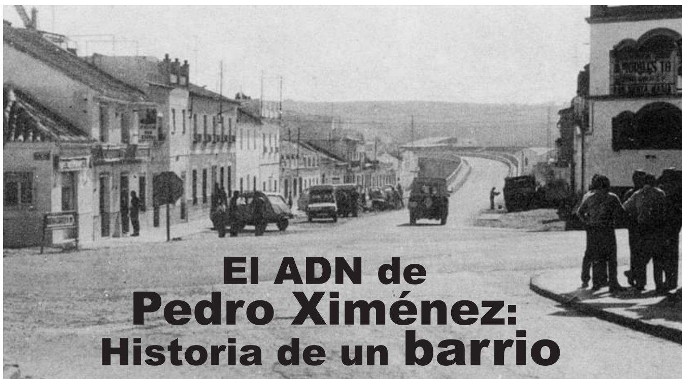
Cruce de Santa María, entre la avda. Marqués de la Vega de Armijo y la carretera de Nueva Carteya, 1984. Ed. BIM 37
