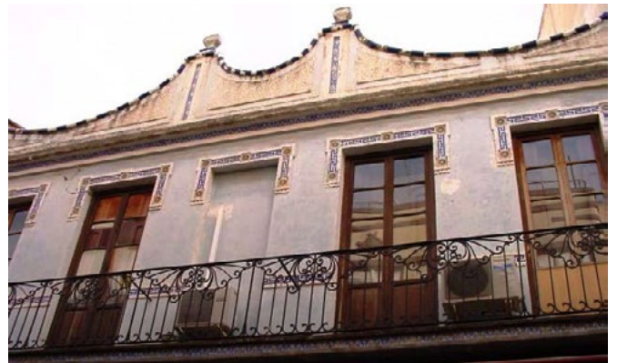
Remat de la façana modernista del Casino dels Pobres
