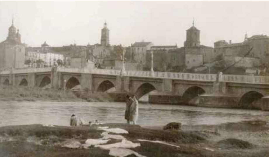
EL PUENTE ENSANCHADO DESPUÉS DE 1915 AGUAS ARRIBA
